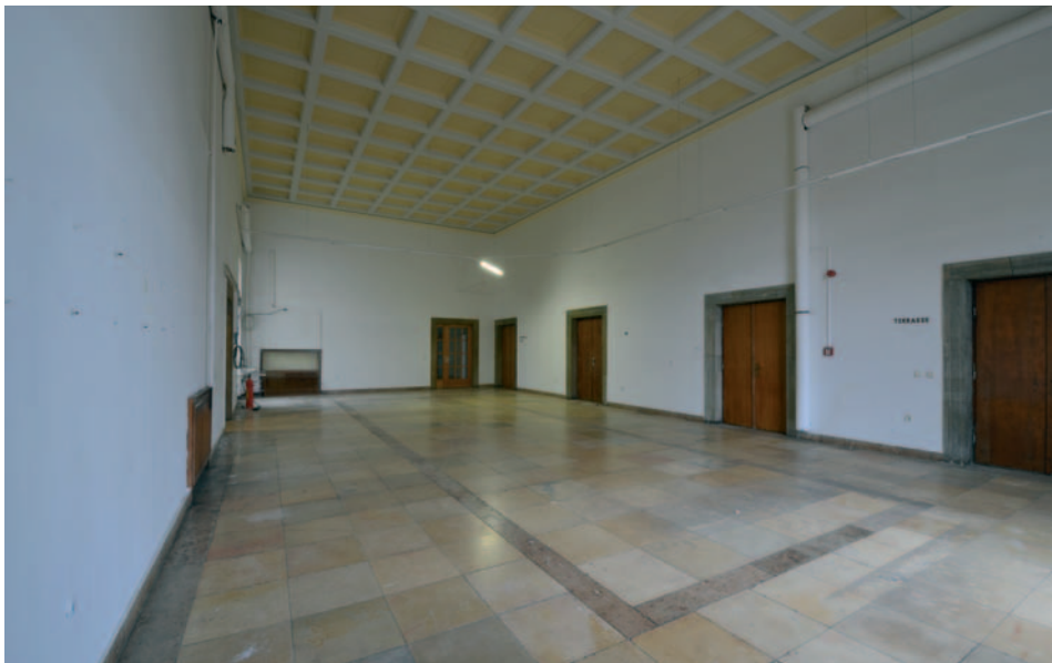
Abb. 10. Landessender Weimar, Solnhofer Boden, ehem. Empfangssaal, Blick nach Süden, 2011. (Aufnahme: Bogner/de Rosa)
