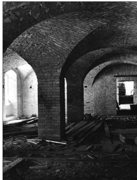
Abb. 5. Nietzsche-Gedächtnishalle, Kreuzgewölbe, Untergeschoss Saaltrakt, Rohbauzustand, 1938. (Goethe- und Schiller-Archiv Weimar, GSA 72/2610)
