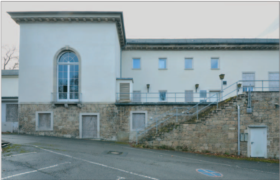
Abb. 2. Sender Weimar, Zwischengeschoss, Außenansicht, Blickrichtung Süden, 2011.
