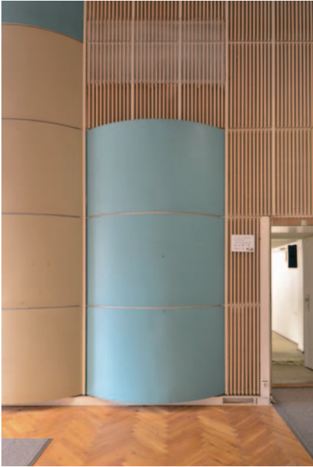
Abb. 11. Detail, Landessender Weimar, großer Sendesaal, Akustikkörper, 2011. (Aufnahme: Bogner/de Rosa)
