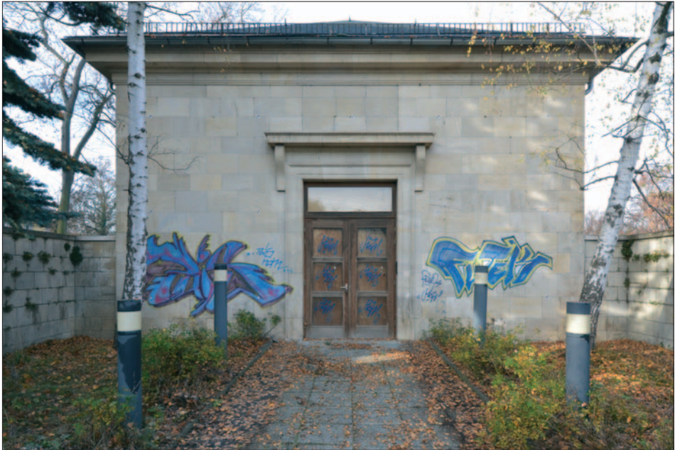
Abb. 1. Gebäude Humboldtstraße 36a, Eingangssituation, 2011.
